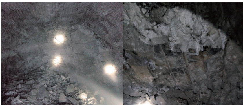
(b) 新方案(300mm超深)爆破后断面图及半眼痕图
